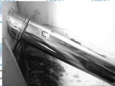
Il canale da fumo deve essere saldamente fissato a tenuta all'imbocco del camino o condotto intubato, senza sporgere all'interno, l'asse del tratto terminale di imbocco e l'asse del camino devono intersecarsi.
